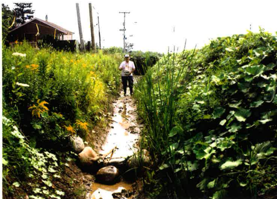
Figure 7-11-10 Ensemencement de fossés dans le but de contrôler les méfaits de l'érosion pour le lac
