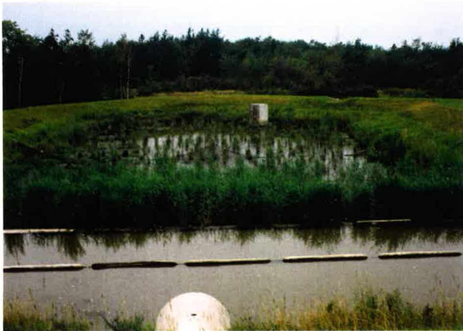
Figure 7-11-8 Le bassin filtre de l'Hétrière fut nettement amélioré en 1993. Plus de 2000 nouvelles phragmites furent plantées. On a ajouté un autre écran à sédimentation; les boudins à filtration furent changés et plusieurs centaines de plans d'épinettes plantés
