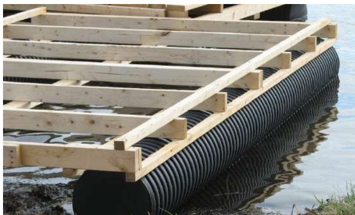
Figure 11: Flotteur en PVC sous la plateforme
