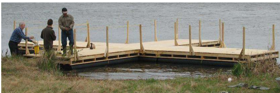
Figure 12: Plateforme flottante prête au déplacement
