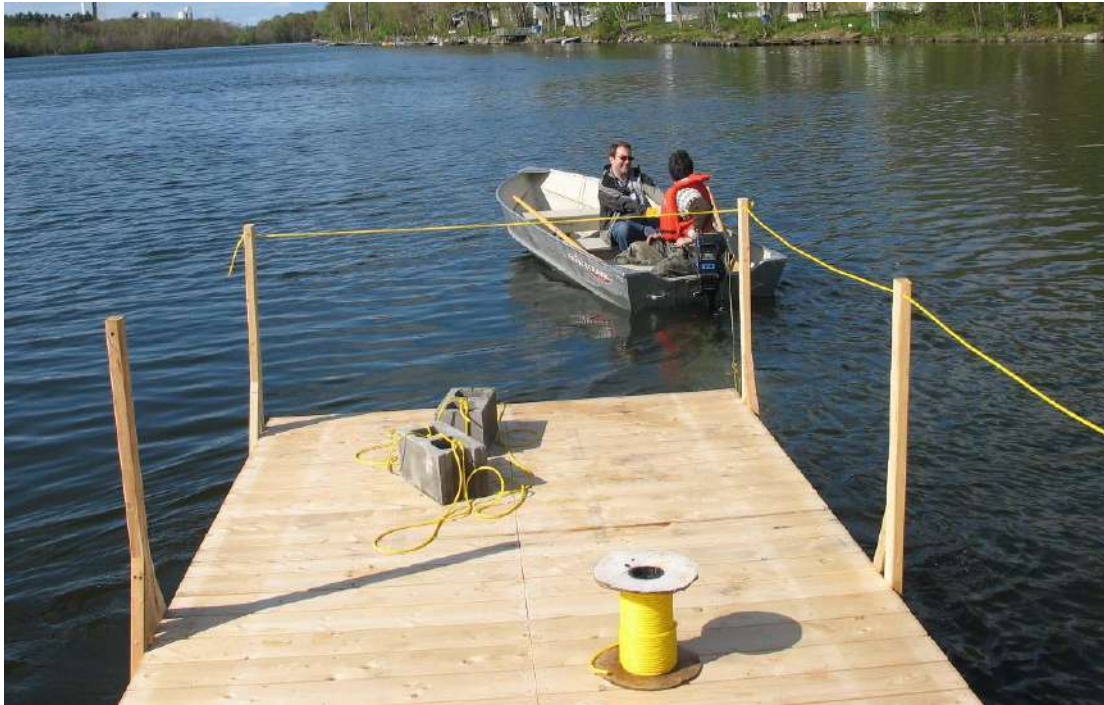
Figure 13: Remorquage de la plateforme vers le site choisi
