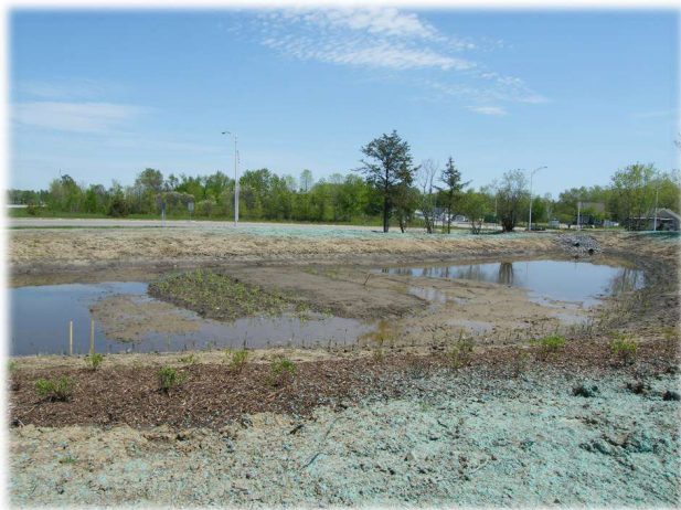
Vue du marais épuratoire, juin 2011
