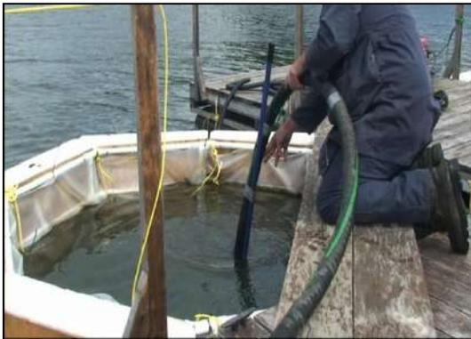
Figure 35 Dragage hydraulique à l'aide d'une motopompe et de son tuyau d'aspiration
