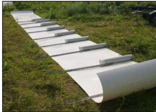
Figure 22 Barrière en PVC pour la protection de la toile de l'enclos « dragage hydraulique »
