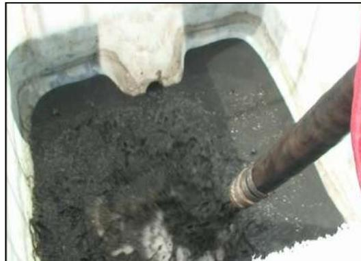
Figure 36 Sédiments refoulés dans une cuve par la motopompe
