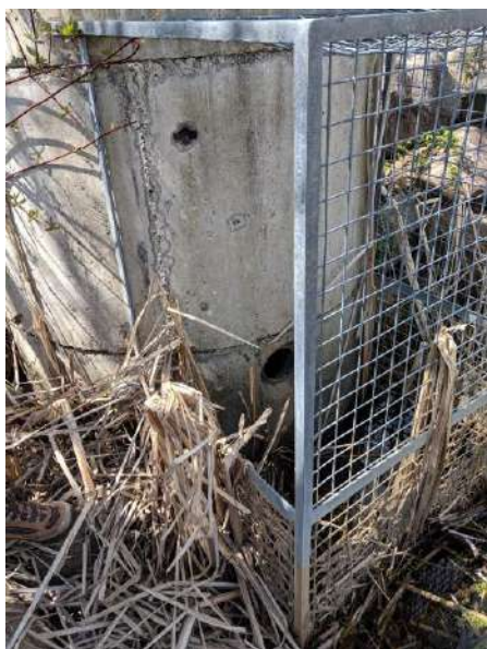
Figure 9 : Structure de sortie d'eau.
