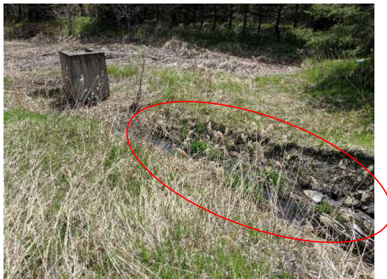
Figure 5 : Canal de sortie d'eau.
