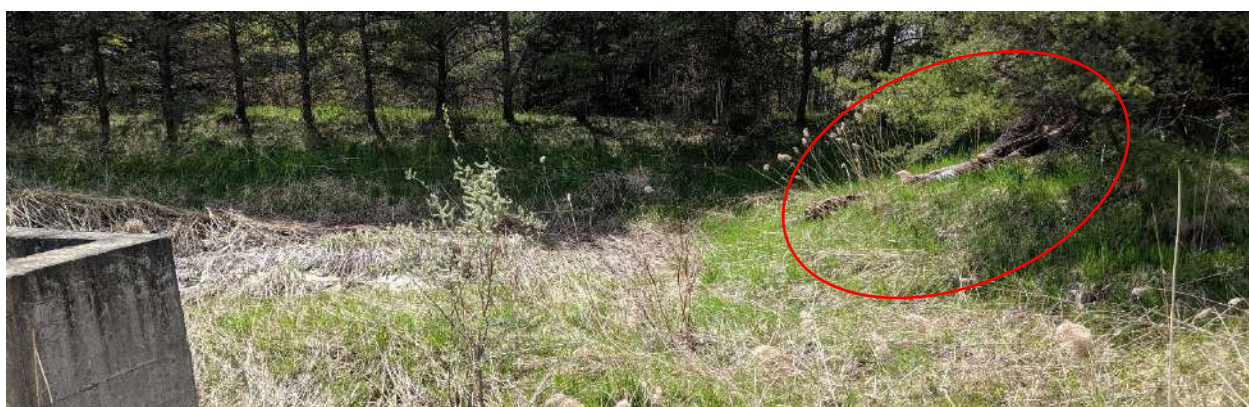
Figure 6 : Conduites désuètes laissées en rive.
