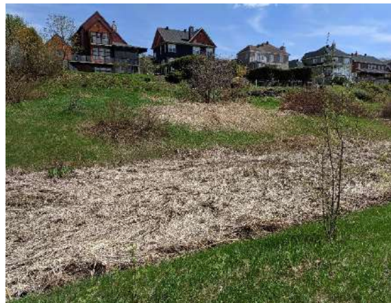
Figure 8 : Bassin de filtration du marais
