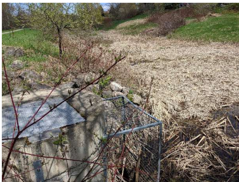
Figure 10 : Structure de sortie d'eau et vue générale sur le marais.
